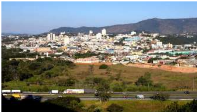
(Cruzamento de rodovias transforma Atibaia em um dos principais eixos logísticos do Estado)
