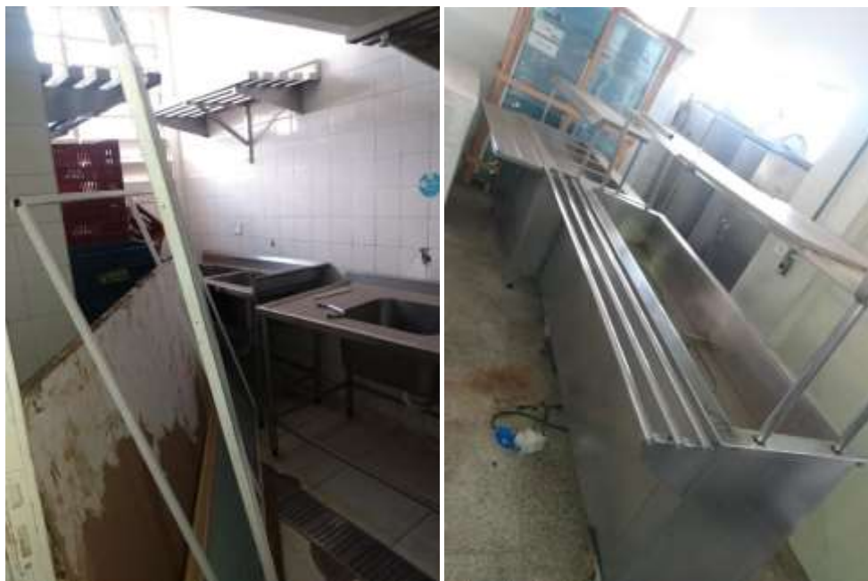
Cozinhas de apoio e salão – equipamentos danificados, furto de torneiras e bandejas de inox, furto de fiação elétrica, coifas e exaustores inativos, dentre outros.
