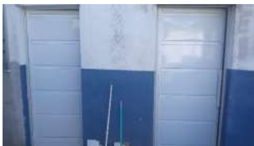
Portas novas instaladas
