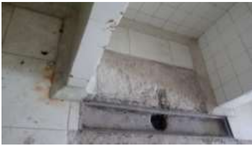
Piso lavanderia – antes
