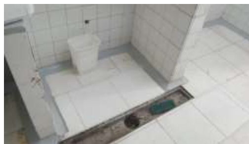
Piso lavanderia - depois
